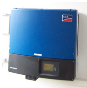
Wechselrichter
