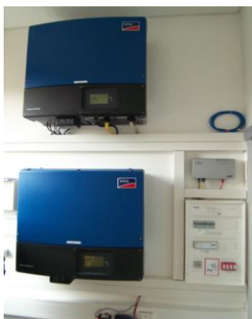
Wechselrichter
